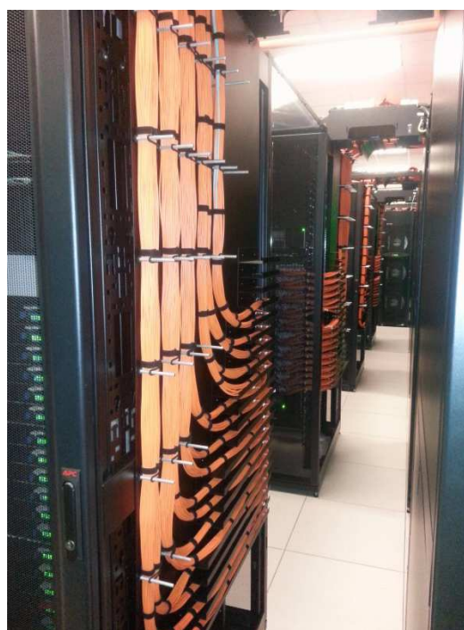
图 2.33: TACC Ranger 与 Stampede 集群的网络交换机。
